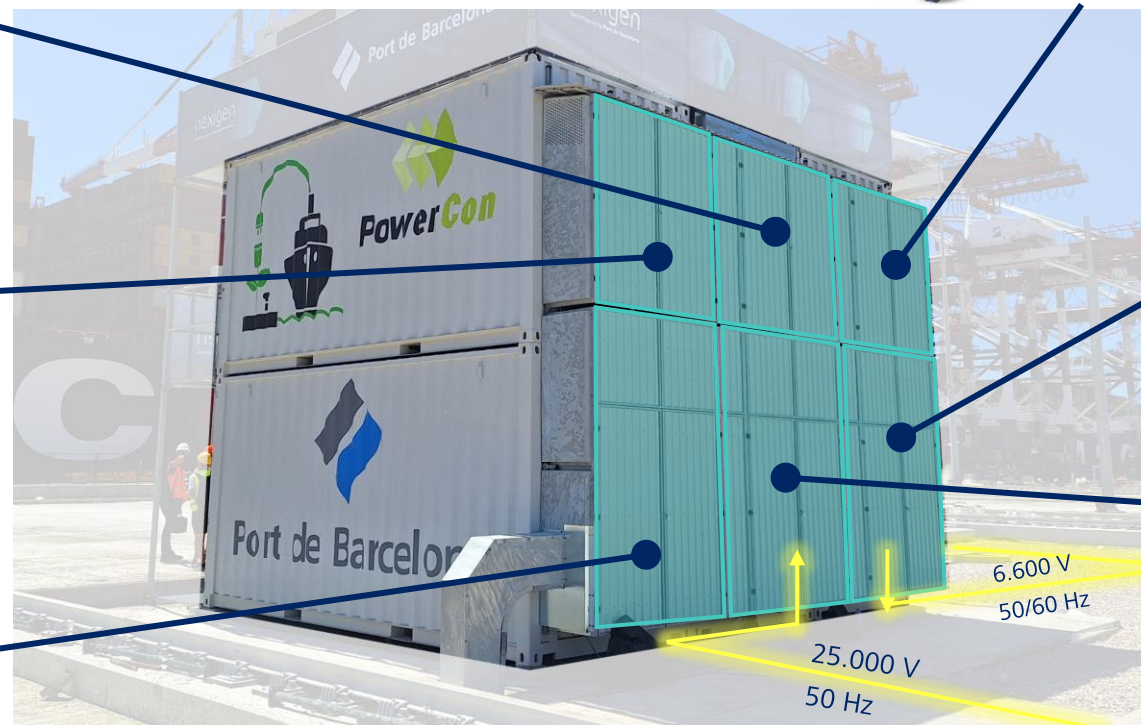
Trafo 1a (25.000/690 V) Trafo 1b (690/6.600 V)
