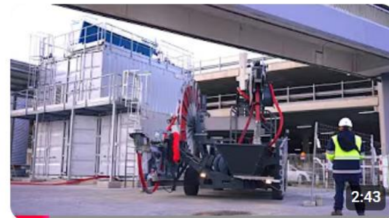
Primer sistema OPS para ferrys del Port de Barcelona en Grimaldi Terminal Barcelona
