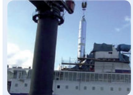
Figuras 9 y 10. Instalación de un scrubber (Fuente: Astander)
